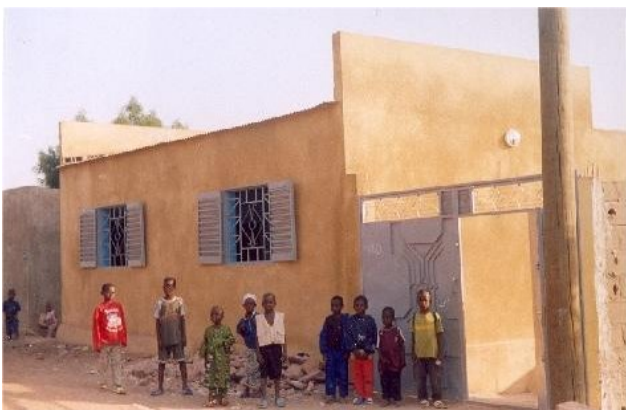
Het nieuwe Centre vlak na oplevering
