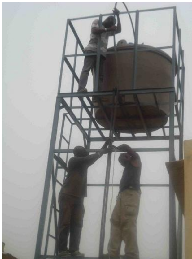
Het waterreservoir wordt aangesloten
