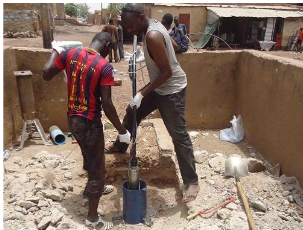
De pomp wordt geïnstalleerd
